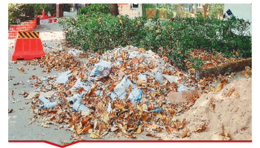
सिम्स में निर्माण के दौरान निकला मलबा बिखरा हुआ है।
